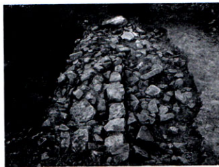
fig. 3 - Monastero di Gravago: muro di terrazzamento
